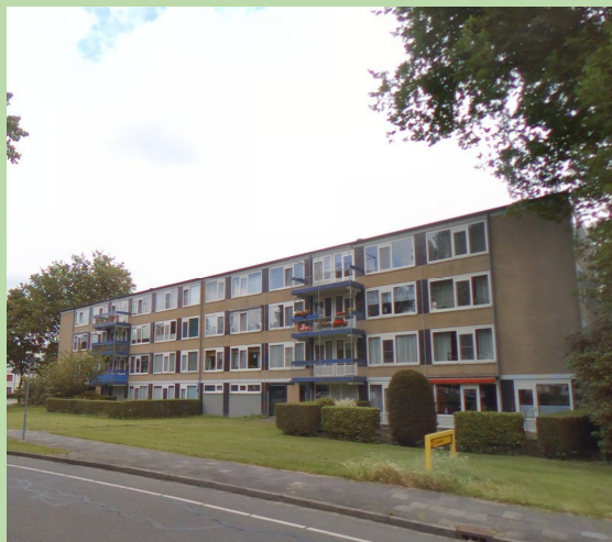
Figuur 2.2 De te slopen flat gezien vanuit de Televisiebaan
