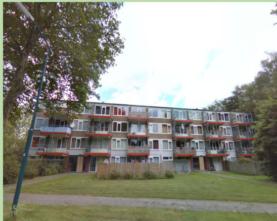
Figuur 2.2 De te slopen flat gezien vanuit de Europalaan
