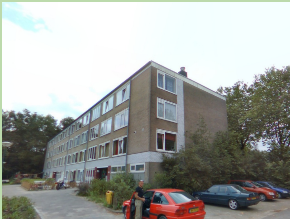
Figuur 2.1 De te slopen flat gezien van het parkeerterrein
