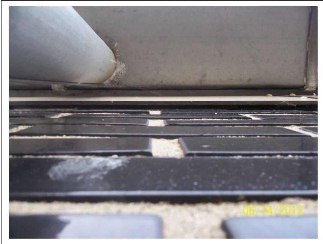
Foto 3. Detailopname ruimte achter de dakranden van de flatgebouwen.
