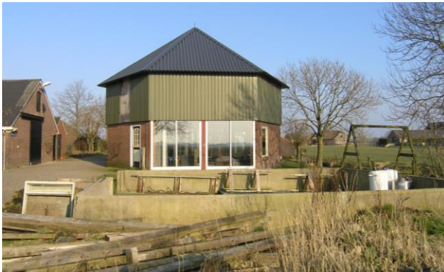
TE SLOPEN BETONNEN SILO (21 FEBRUARI 2018)
