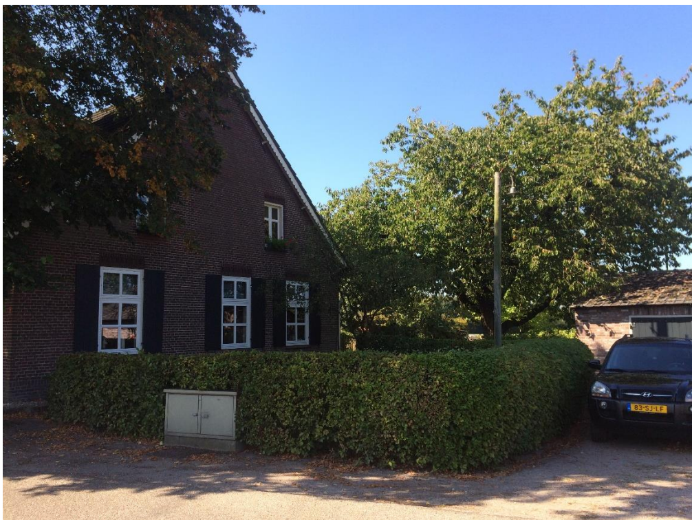
Bestaande beplanting rechter zijgevel
