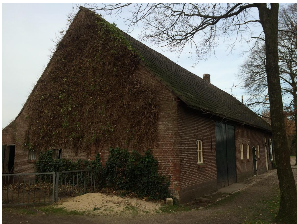
Linker zijgevel bestaande woning
