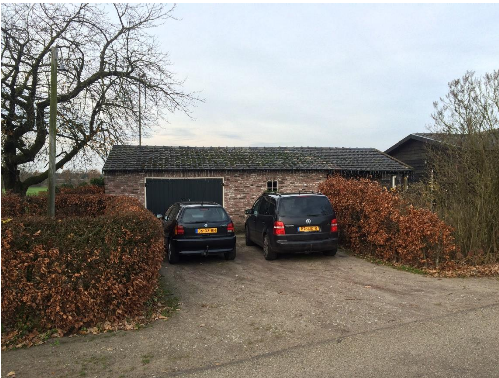
Bestaande in/uitrit aan de oostzijde van de woning
