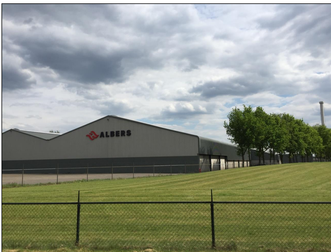
Afbeelding 3.8 Zicht op het bedrijf aan De Peel 1. Op de voorgrond het nog in te richten terrein van het naastgelegen bedrijf.
