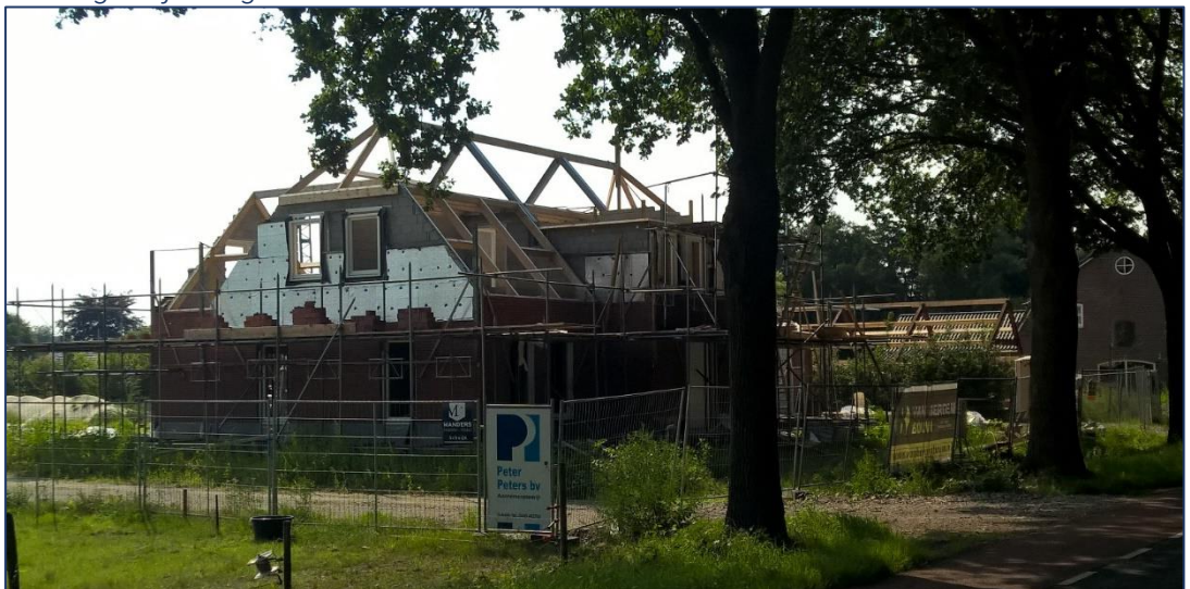
Woning Heijtmorgen 44b in aanbouw
