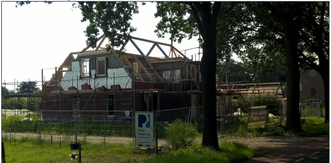
Woning Heijtmorgen 44b in aanbouw
