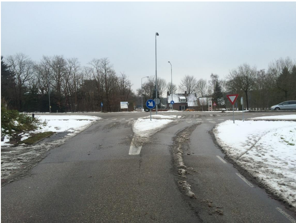
Aansluiting Palmstraat op de N324
