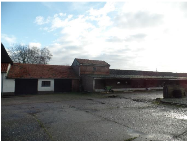
Fig.4. Links aanbouw van woonhuis (no.2) en rechts melkveestal (no.3)
