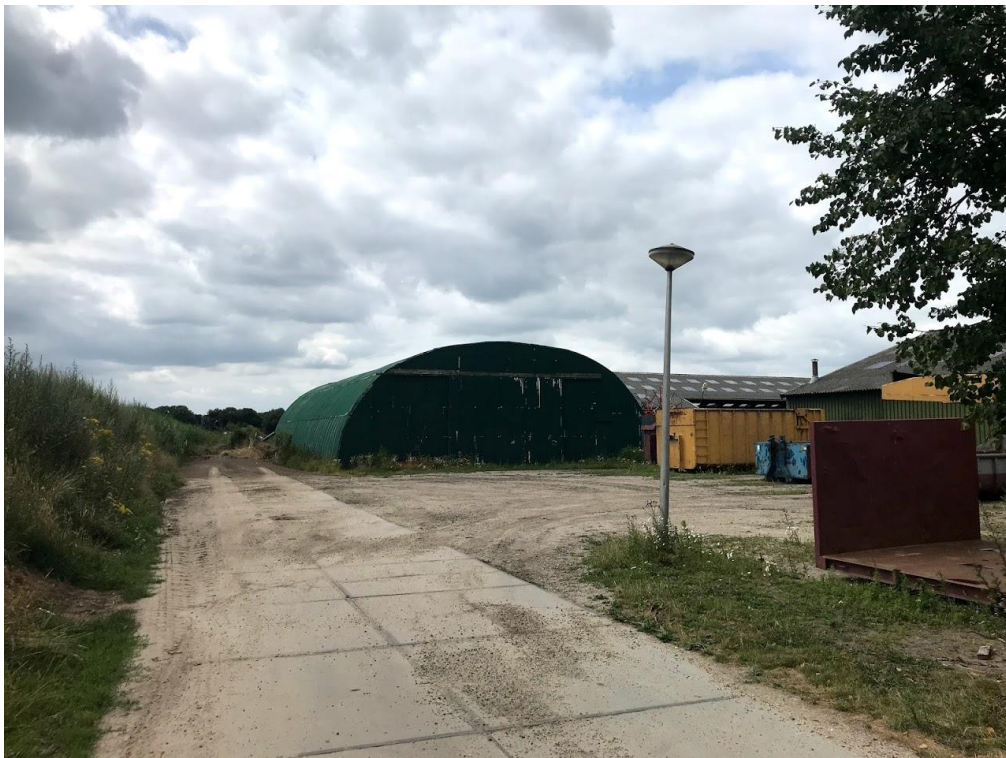
Bestaand bouwwerk ter hoogte van de beoogde nieuwe bedrijfsloods
