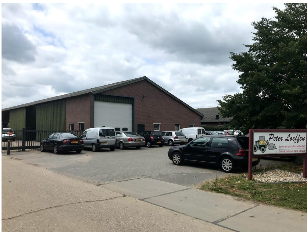
Bestaande parkeervoorzieningen direct ten oosten van het bedrijfsbouw
