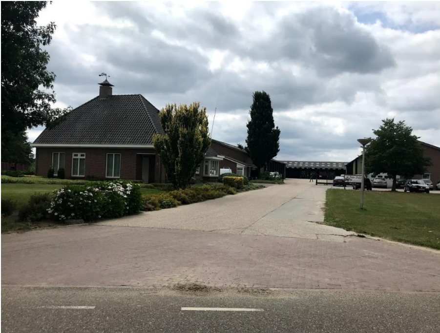
Noord- oostzijde plangebied met bestaande inrit
