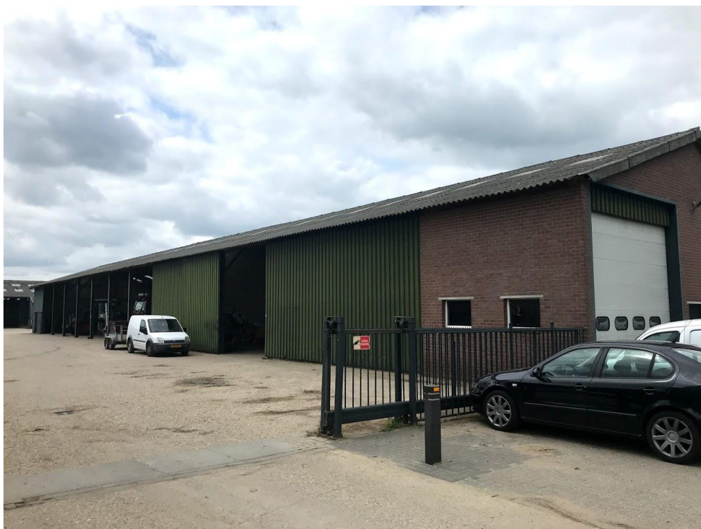
Bestaand bedrijfsgebouw zoals aanwezig aan de noord- oostzijde van het plangebied
