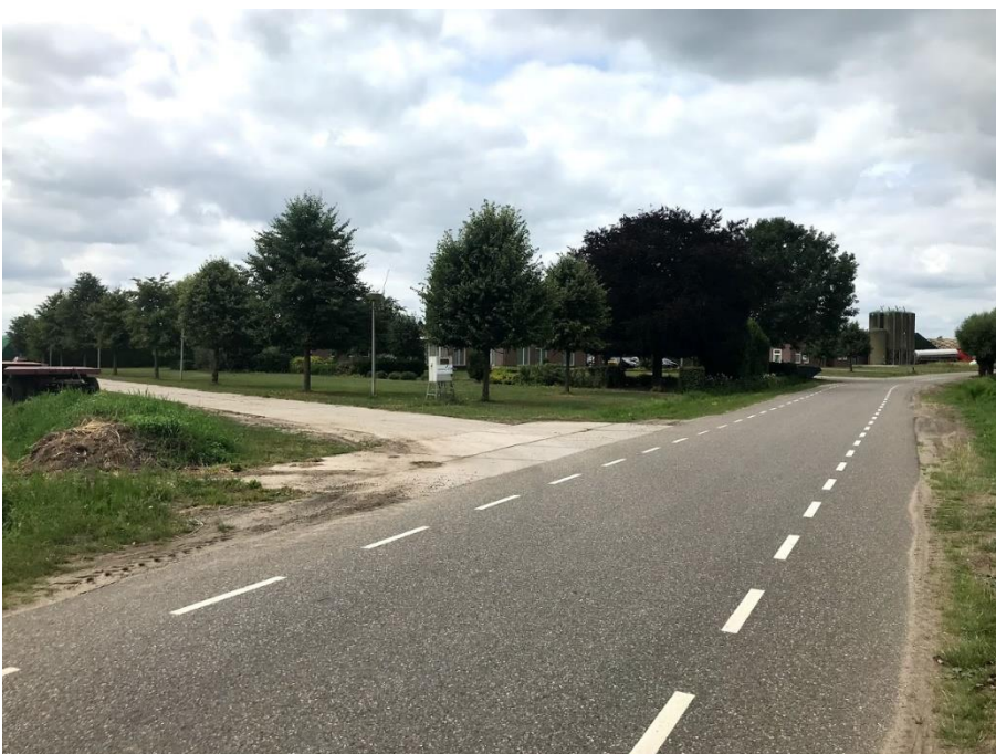
Zuid- oostzijde plangebied met bestaande inrit
