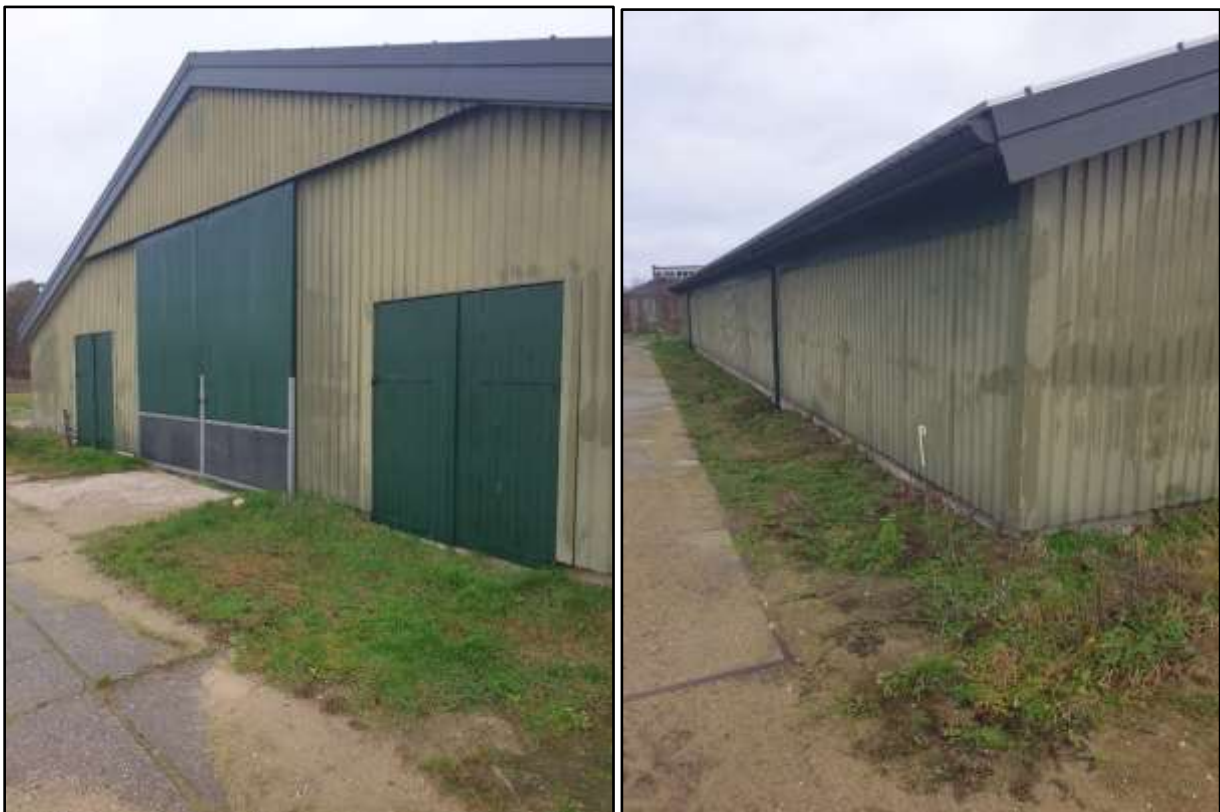
Afbeelding 19: Buitenzijde te verbouwen ligboxenstal
