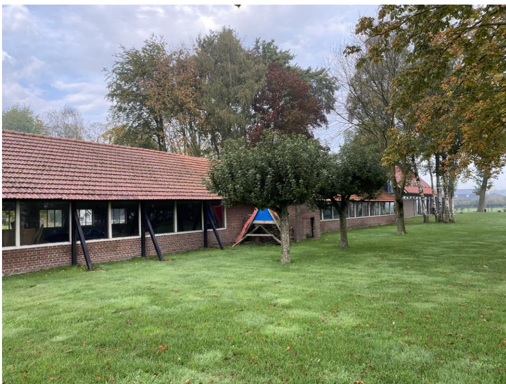
Schuur ten behoeve van opslag
