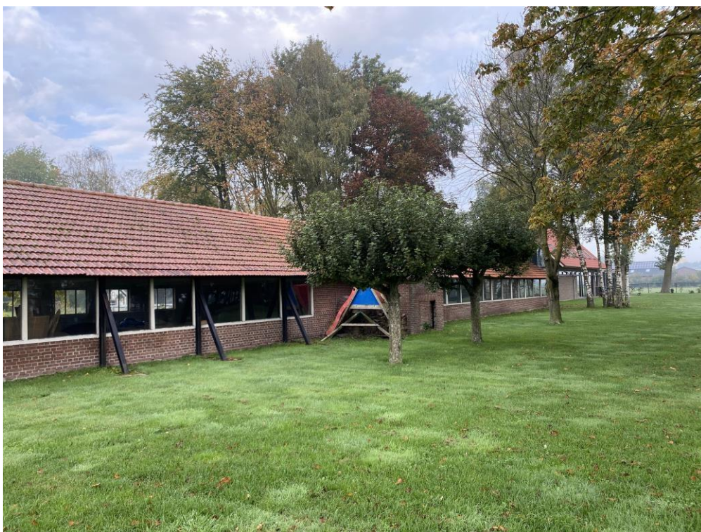
Schuur ten behoeve van opslag
