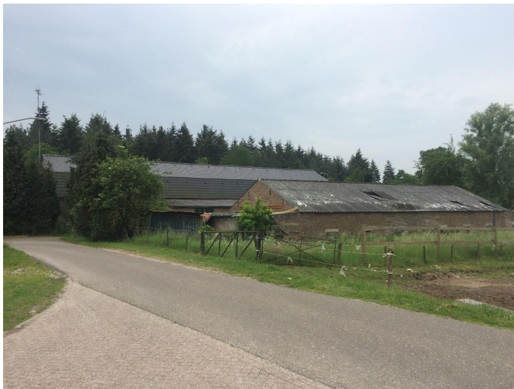
Voormalig aanzicht westelijk perceel gezien vanaf de Munstraat (richting het zuidwesten)
