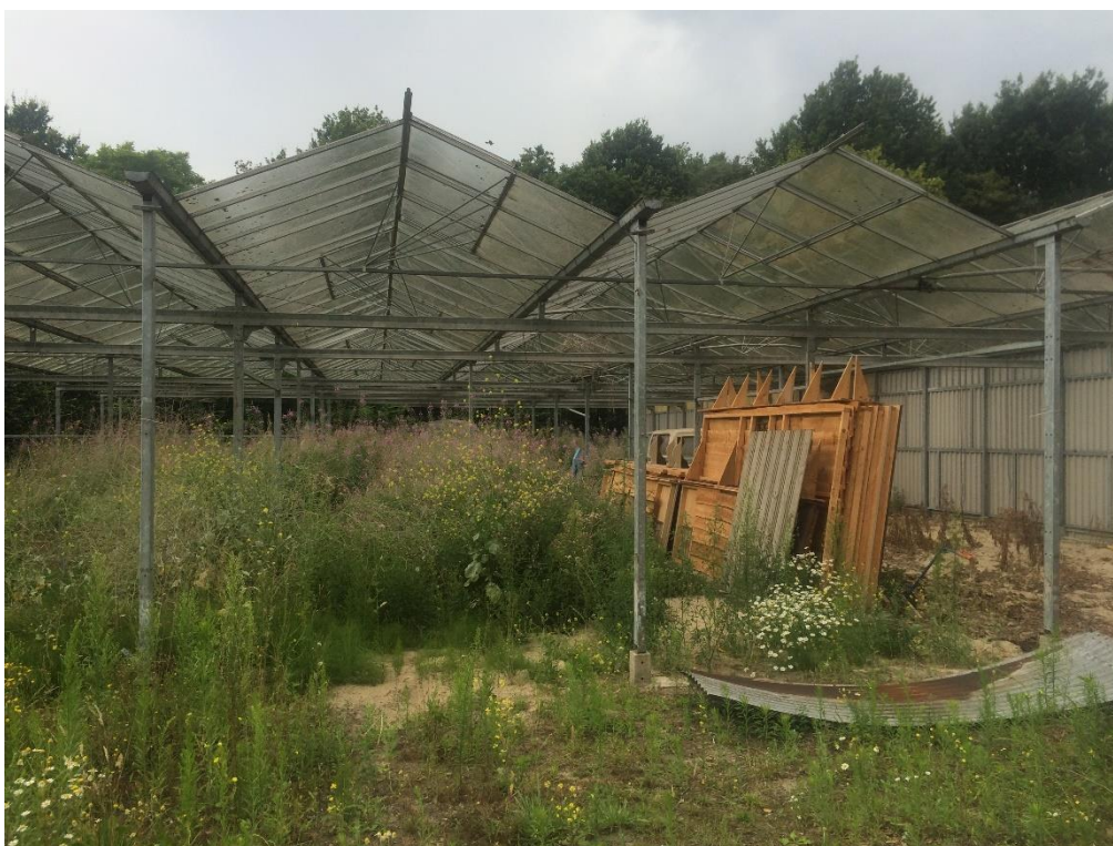
Kassen van het voormalige tuincentrum zoals aanwezig op het noordelijke perceel
