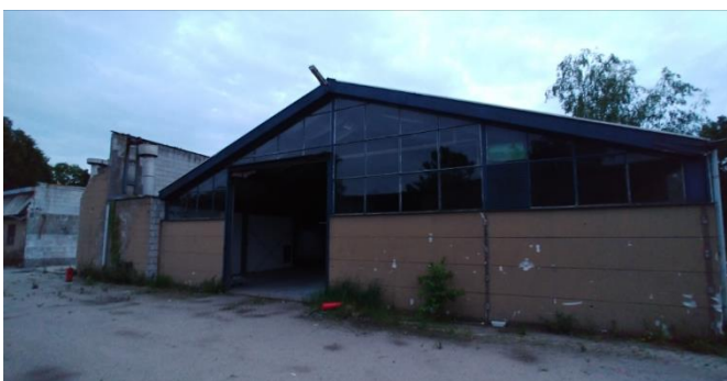
Figuur 4: Zuidelijke bedrijfshal gezien vanuit noorden, vanaf de binnenplaats
