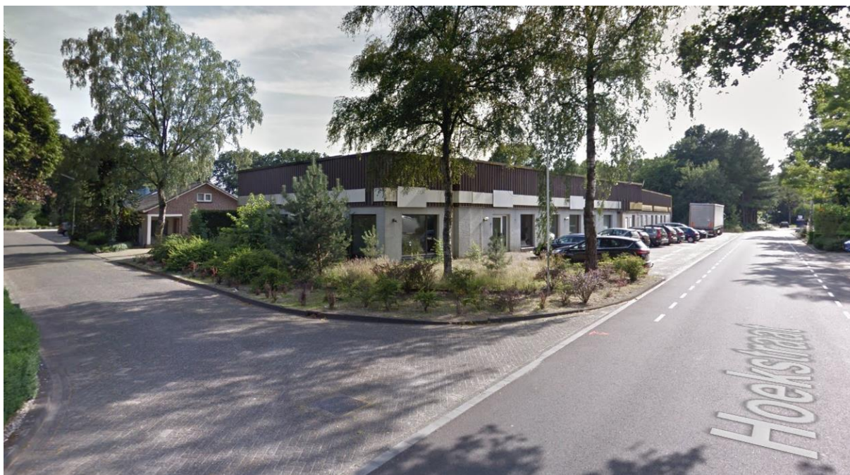
Figuur 2.1: Huidige bedrijfsbebouwing plangebied (bron: Google Maps)
