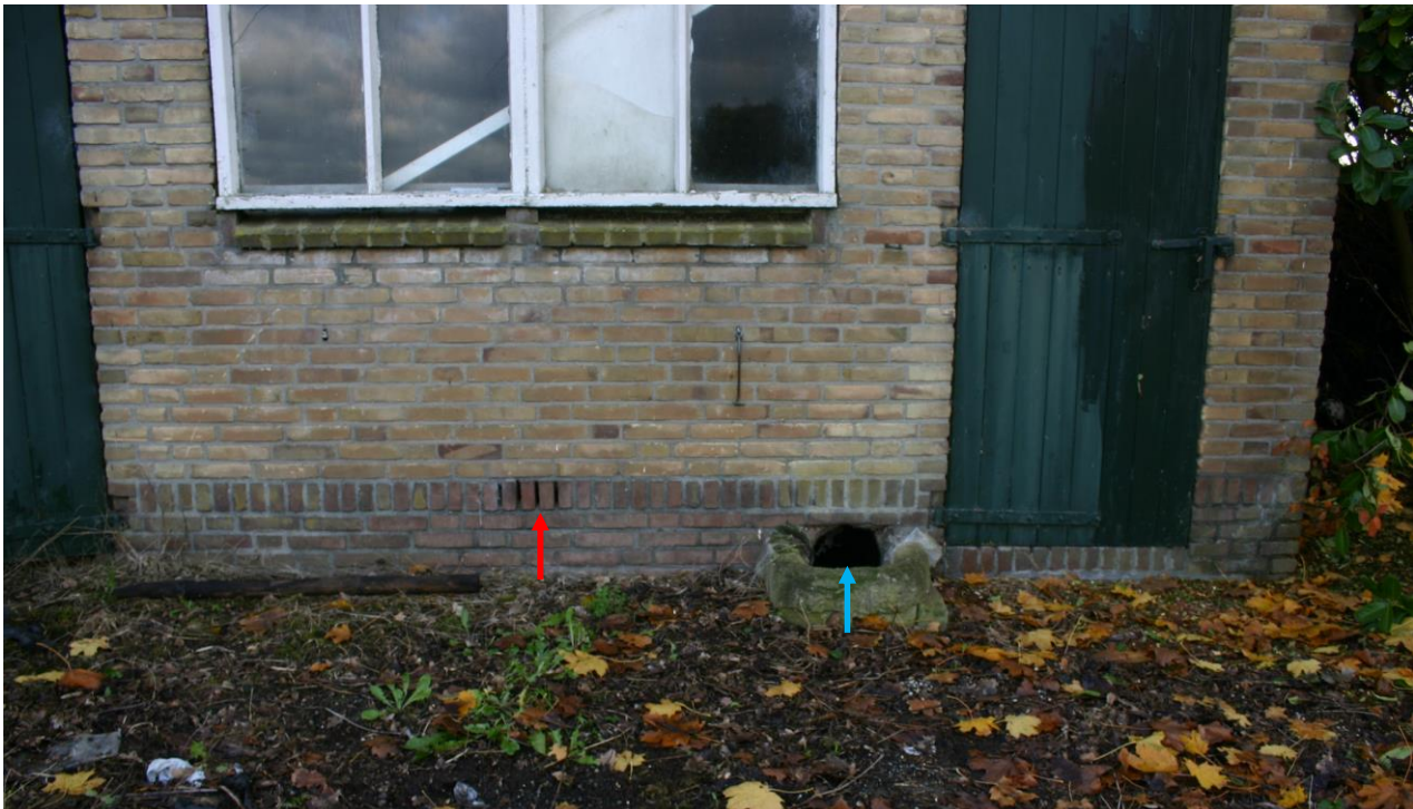
Figuur 4.5.4. In de gevels van de voormalige koeienstallen bevinden zich ventilatiegaten (rode pijl) op kniehoogte en gaten (blauwe pijl) naar de gierkelders.
