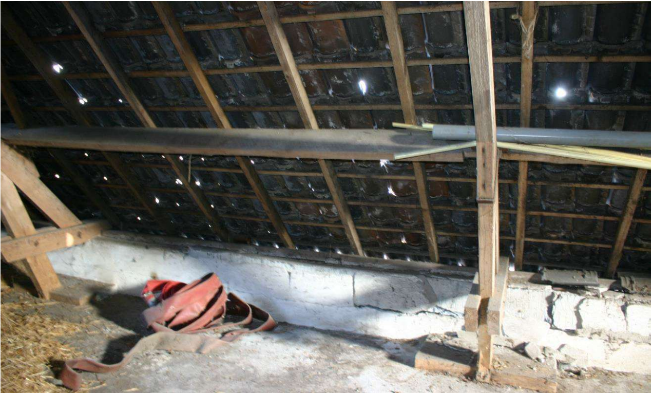
Figuur. 4.5.1. De zolder van de voormalige koeienstal geeft uilen, dankzij de volledig intacte ramen, geen toegang. Voor vleermuizen is deze echter makkelijk bereikbaar, door de gaten in de dakbedekking.
