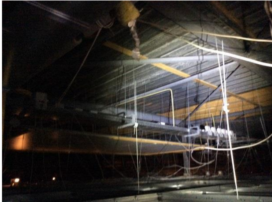
Winkel met verlaagsysteemplafond
