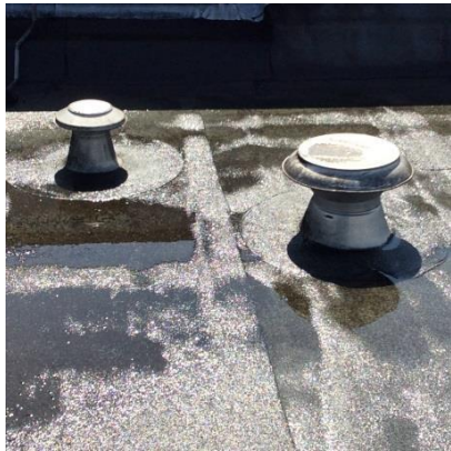
Ontluchting metaal met metalen of kunststof doorvoeren
