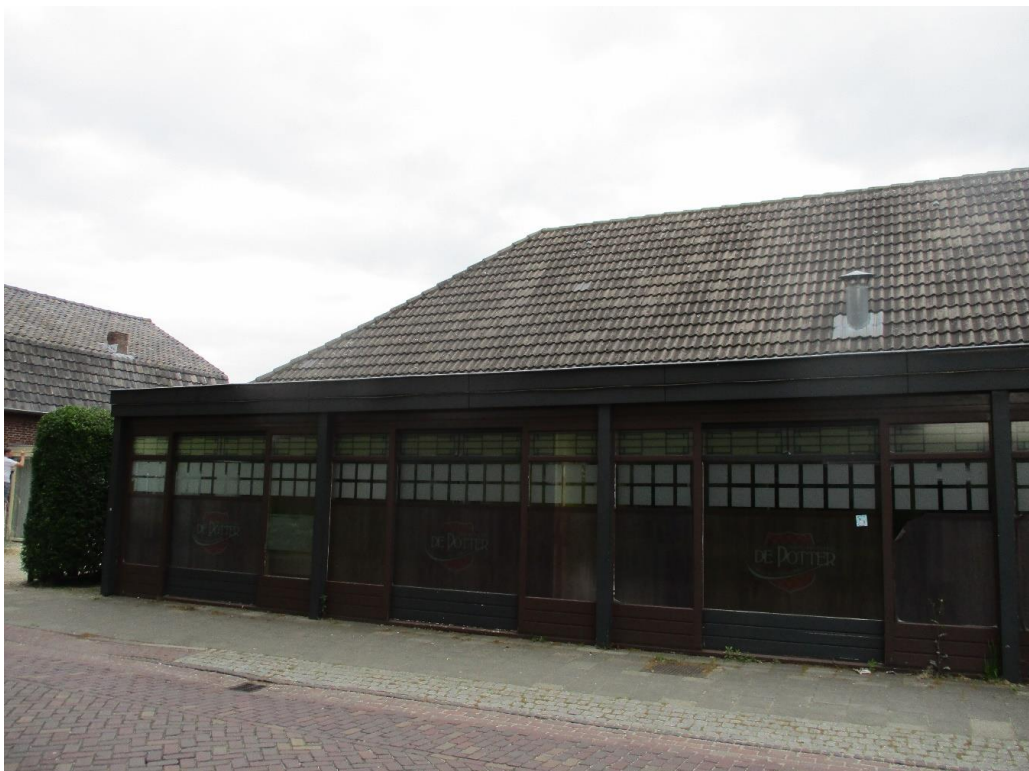
Figuur 2 Aan de zuidwestzijde is een houten aanbouw aangelegd tegen het pand.
