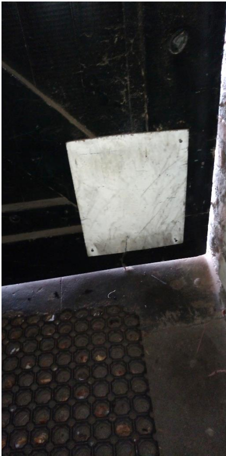
Buitendeur met kattenluik, kattenluik aan binnenzijde dichtgemaakt
