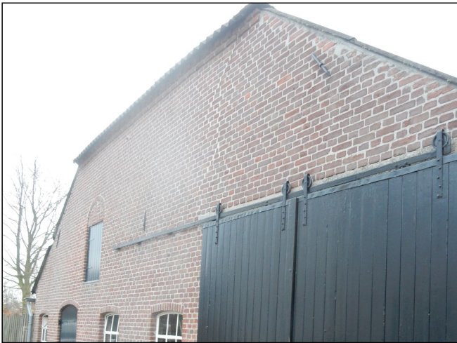
Figuur: achtergevel van de boerderij. Het achterhuis heeft geen spouwmuur waar vleermuizen verblijven in kunnen hebben.
