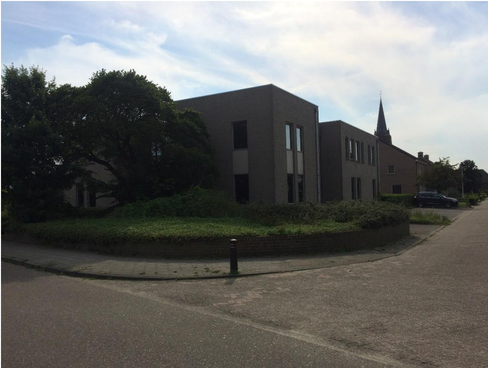
Bestaand kantoorpand gezien vanaf de hoek Vlasroot/Brouwerspad
