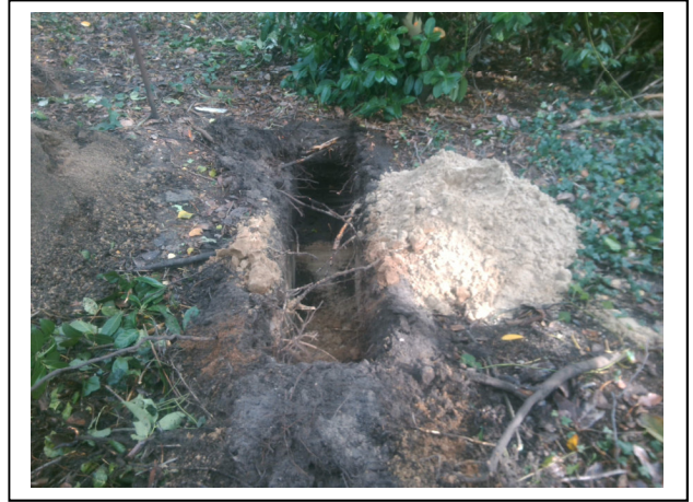
Foto 8. Asbestinspectiesleuf 108
