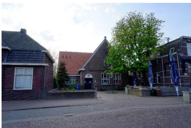
Parochiegebouw aan de Kerkstraat.
