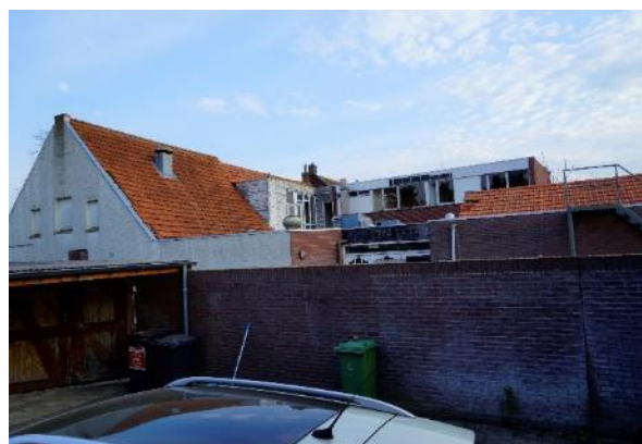
Achterzijde van Salt and Pepper. Verval van het gebouw en gebroken ramen is goed zichtbaar.
