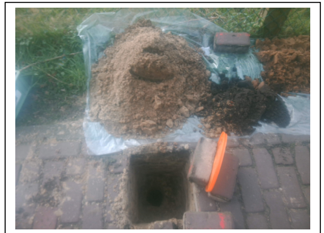
Foto 14. Asbestinspectiegat 14
