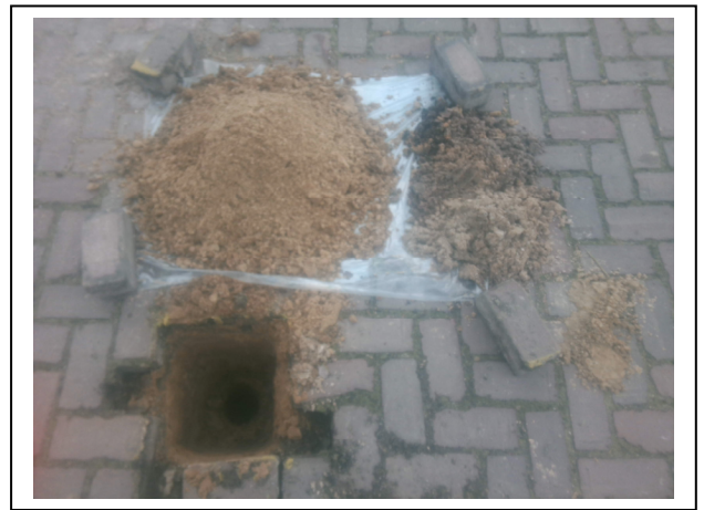
Foto 10. Asbestinspectiegat 10
