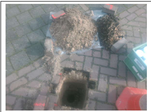
Foto 9. Asbestinspectiegat 09
