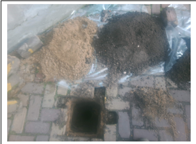
Foto 7. Asbestinspectiegat 07
