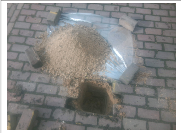
Foto 25. Asbestinspectiegat 25
