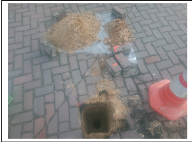
Foto 13. Asbestinspectiegat 13
