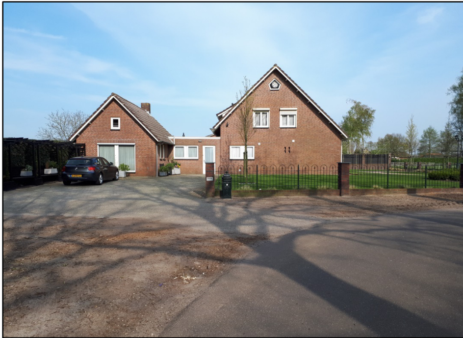
Afbeelding 14: aanzicht woning/tuin, kijkrichting west
