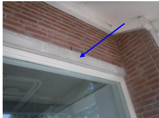
Foto 15 | Betonnen latei boven kozijn
