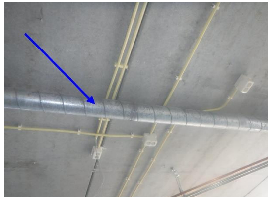
Foto 5 | Metalen ontluchtungsbuizen
