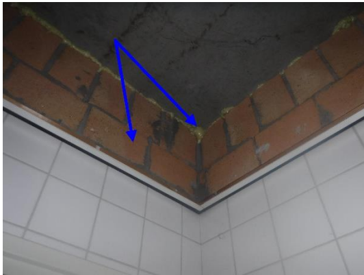
Foto 12 | Gemetselde binnenmuren met pur afdichting
