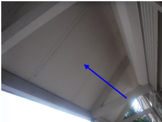
Foto 14 | Isolatiedakplaten op de entree
