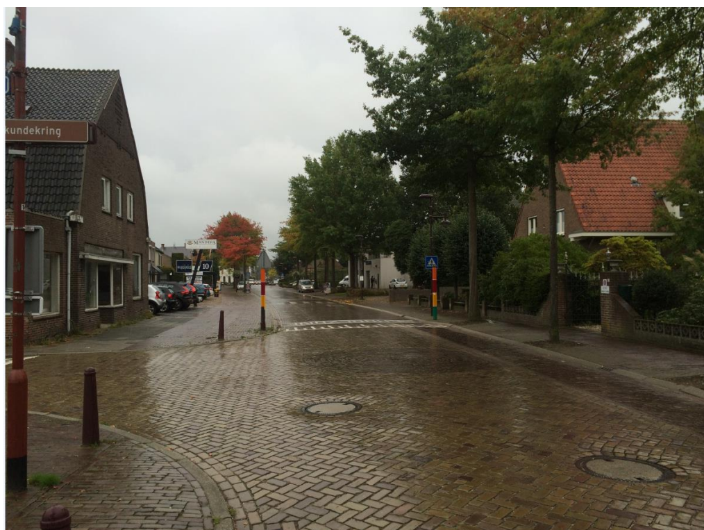
Wegprofiel Runstraat ter hoogte van plangebied (richting het zuidoosten)
