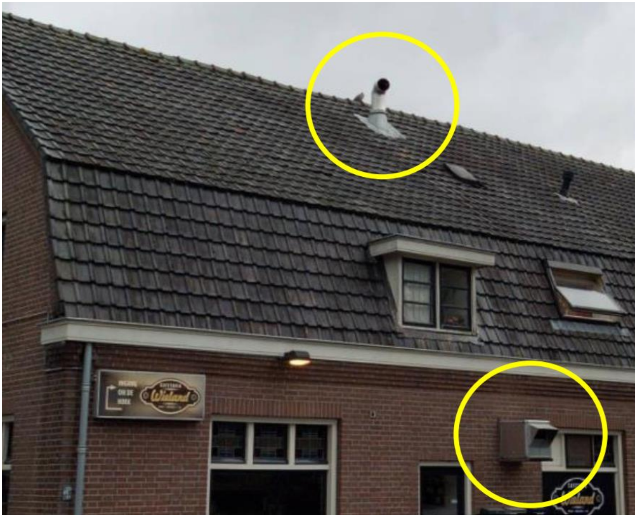
Mogelijke locatie afvoerpijpen geel omcirkeld
