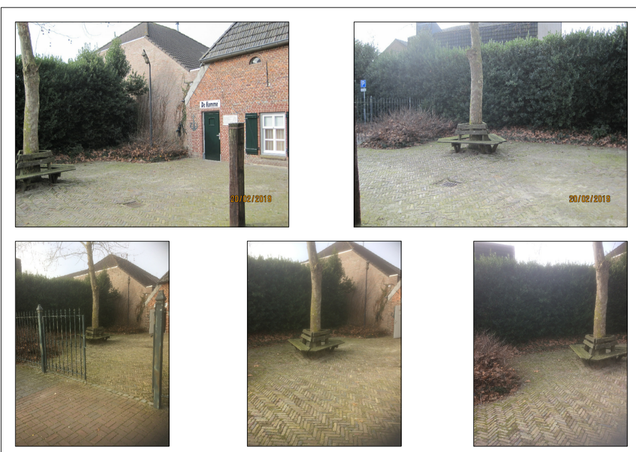
Foto's bestaande situatie
