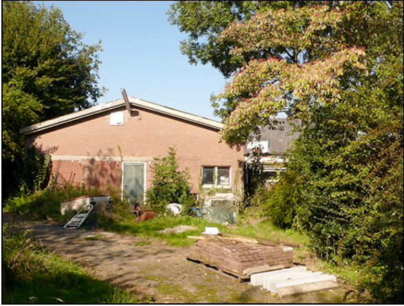
Achtergevel zalencentrum met verharde omgeving
