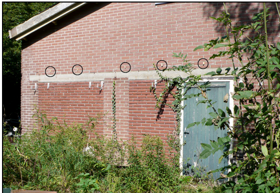
Afbeelding: Afgedichte stootvoegen met proppen aan achtergevel en een detail daarvan
