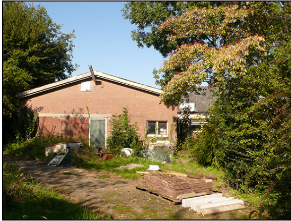
Achtergevel zalencentrum met verharde omgeving
