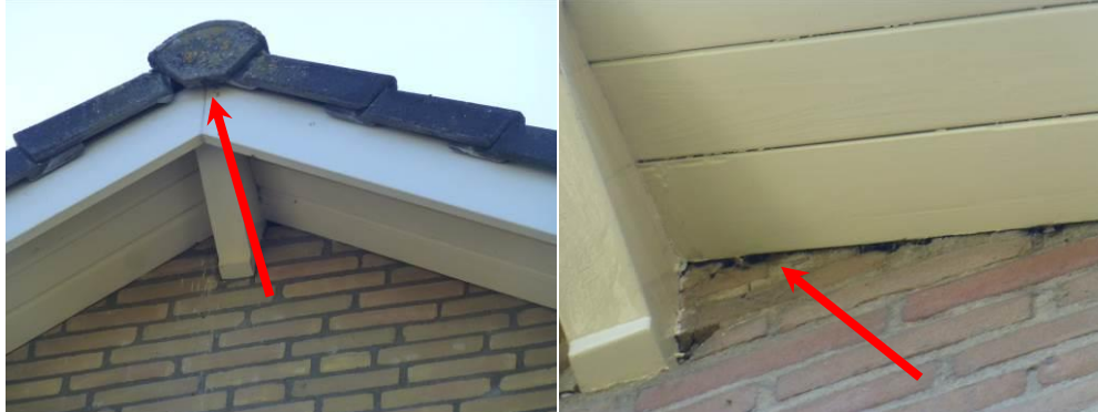
Figuur 5.2. Kieren en ruimtes onder de dakpannen en in de nok die vleermuizen mogelijk toegang geven tot zwaar beschermde vaste rust- en verblijfplaatsen.
