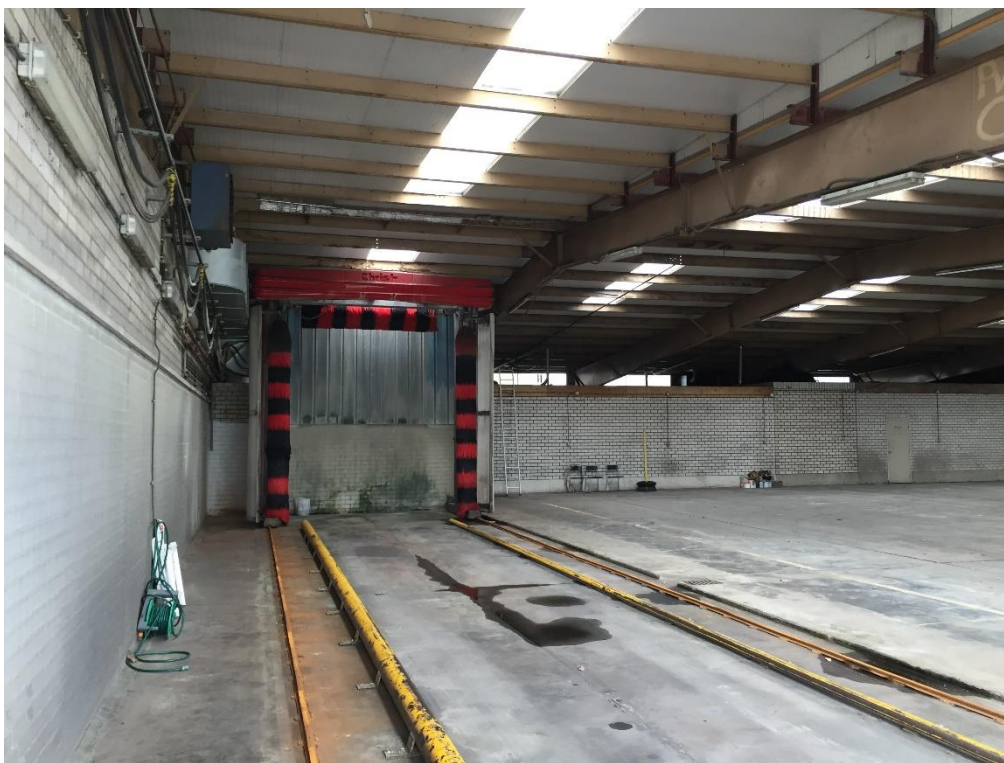
Inpandige wasplaats bedrijfsgebouw A
