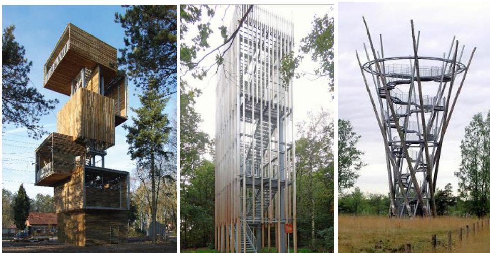
Uitkijktoren Brandtoren te Reusel, uitkijktoren de Stokte te Dalfsen en de Flaestoren op Landgoed de Utrecht
