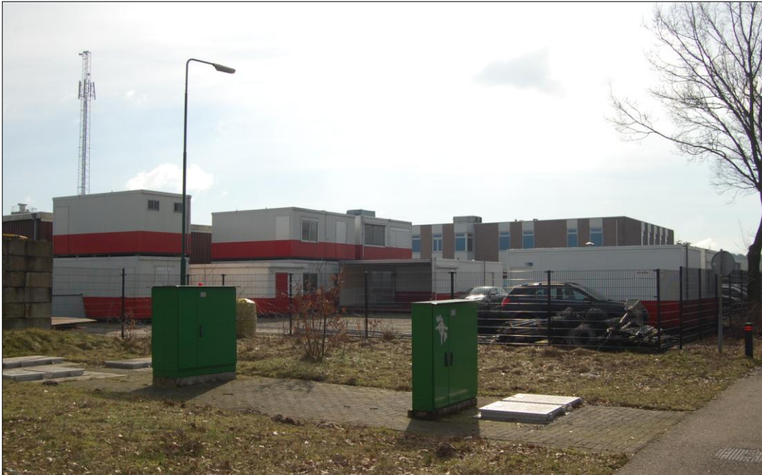
1 nutsvoorzieningen en zendmast op bedrijventerrein De Louwstraat
