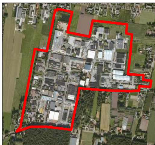
2 luchtfoto plangebied Louwstraat
