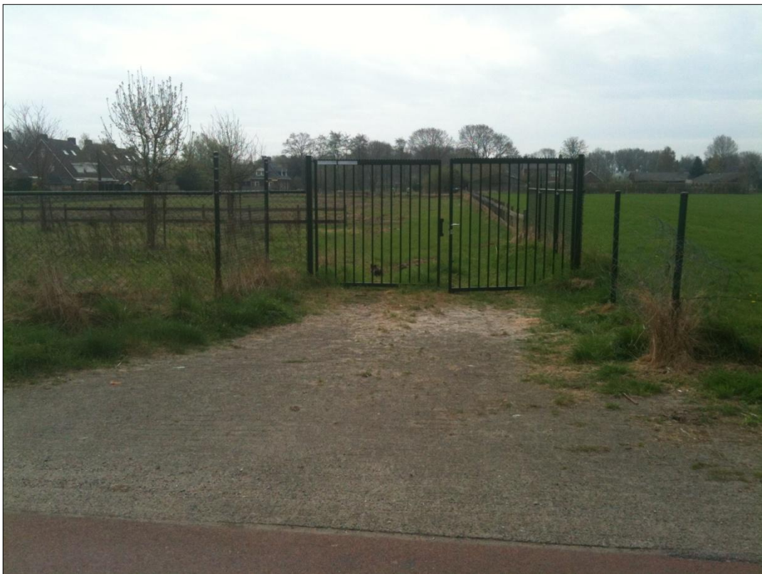
Afbeelding 20: reeds deels aangelegde inrit
