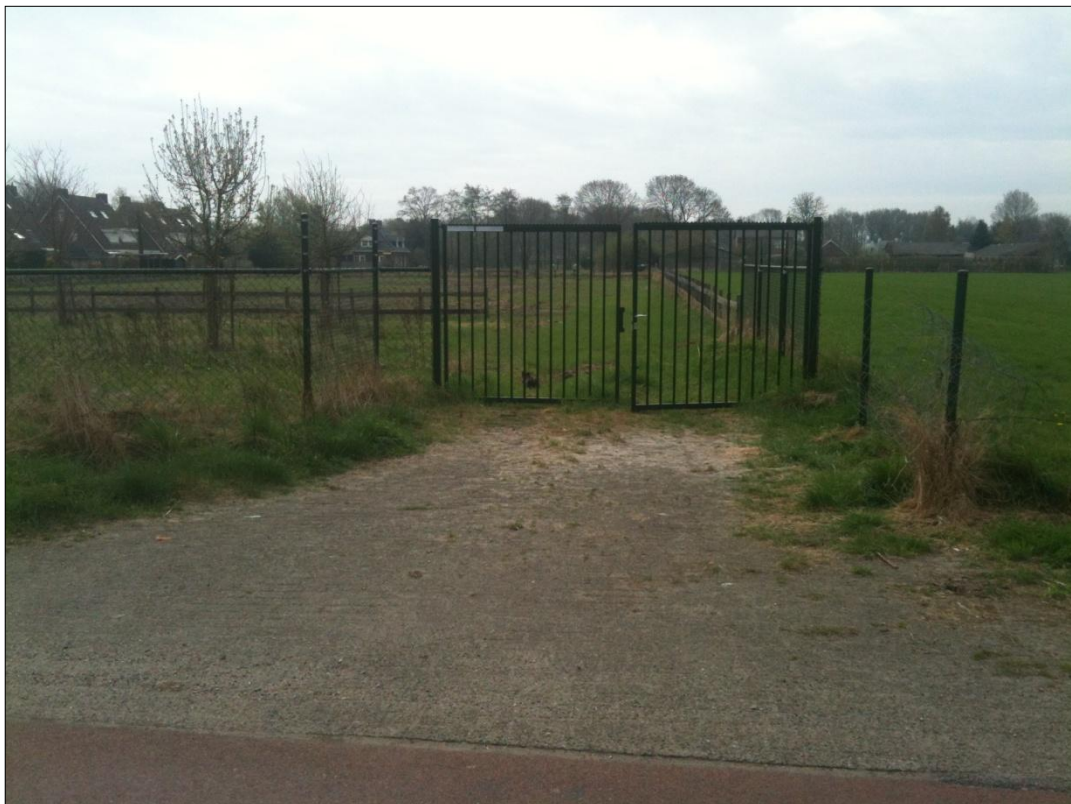
Afbeelding 21: reeds deels aangelegde inrit
