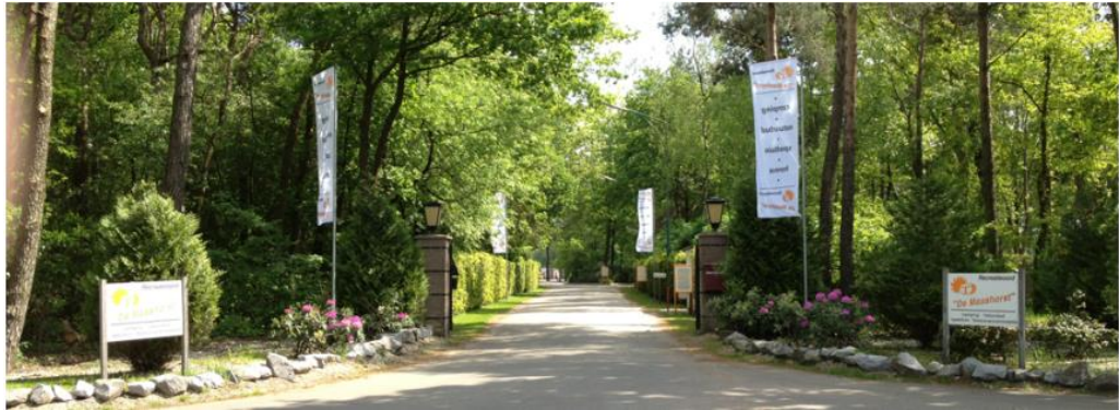
Huidige hoofdotsluiting aan de zijde van de Palmstraat
