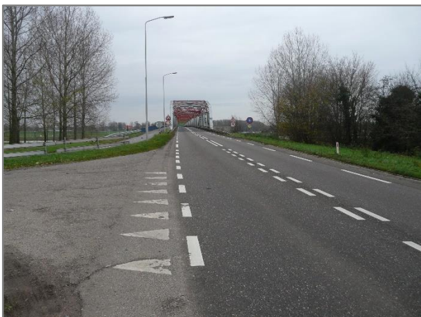
Foto 226: Maasbrug vanuit N324 gezien
