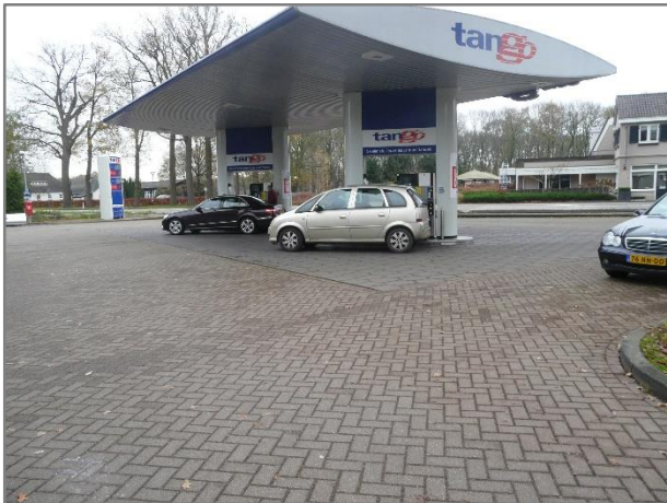
Foto 98: Afleverinstallatie met pompeilanden \Tango Tankstation
