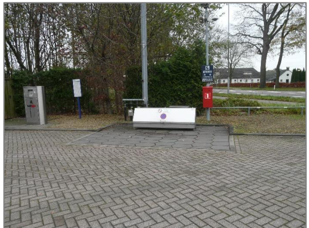
Foto 101: vulpuntenbak en ontluuchtingspunten
