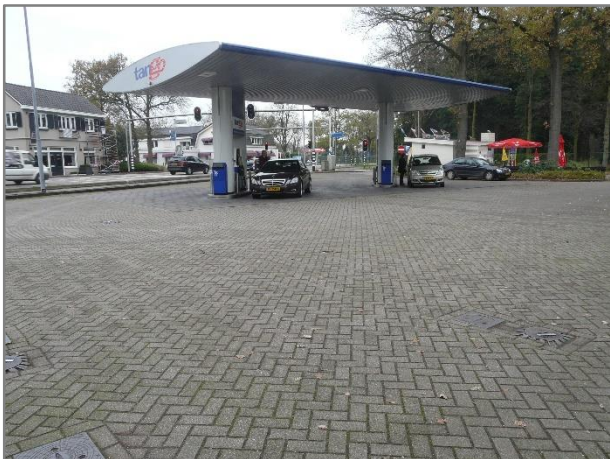
Foto 100: Afleverinstallatie met pompeilanden
