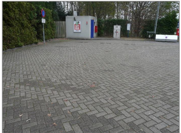
Foto 99: Locatie ligging ondergrondse tank met rechts vulpuntenbak en ontluuchtingspunten
