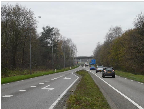
Foto 5: Zicht op viaduct over de A50
