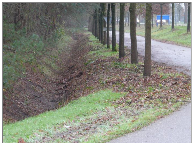
Foto 14: Sloop/watergang zuidelijk van parallelweg
