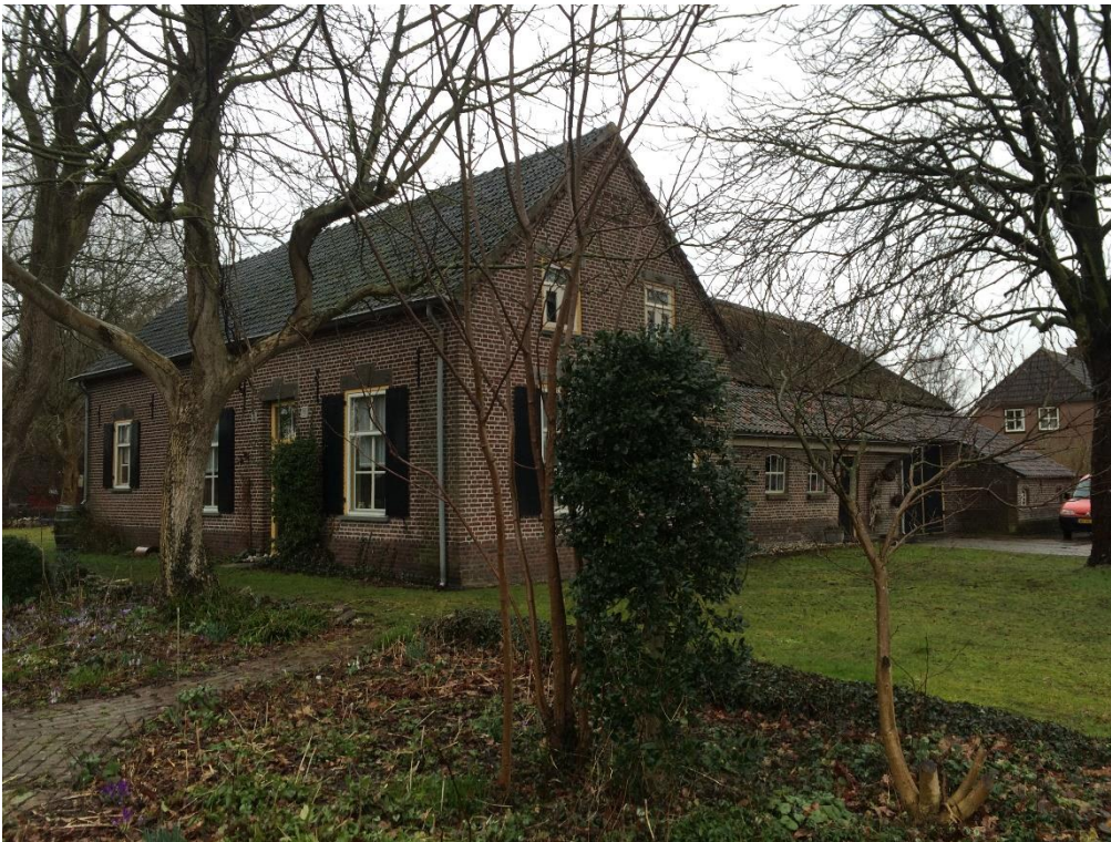
Linker zijgevel bestaande woning
