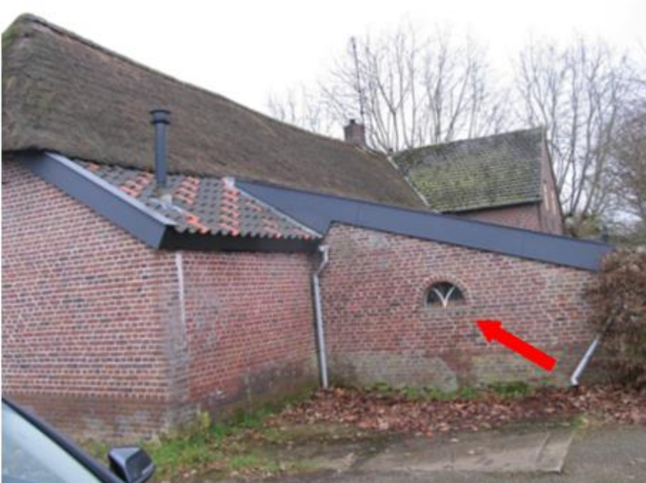
Te slopen uitbouw
