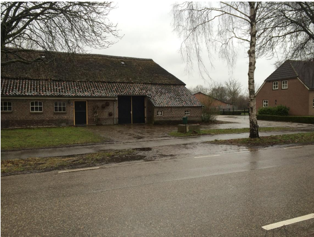
Bestaande inrit aan de oostzijde van het plangebied
