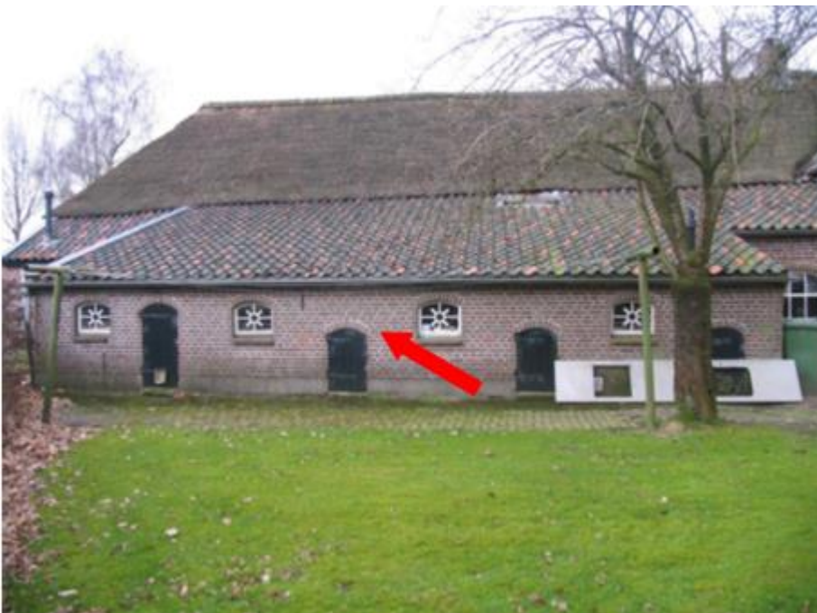
Te slopen uitbouw
