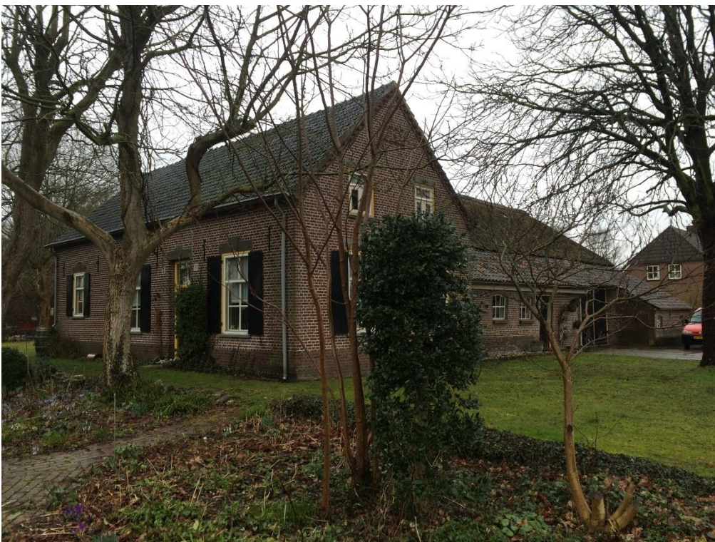
Linker zijgevel bestaande woning
