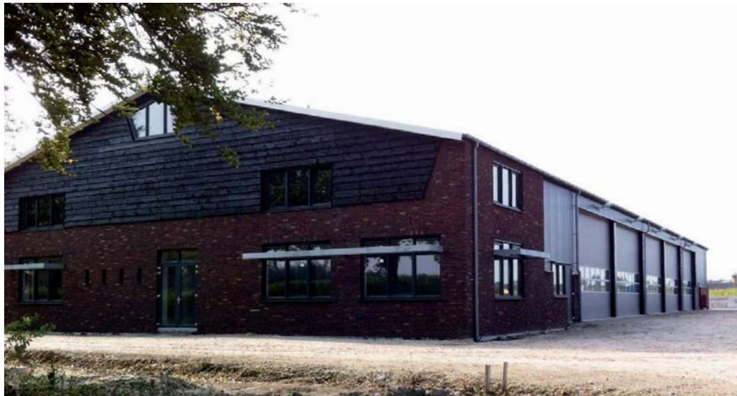
Fig. 15: referentie loods met gepotdekselde delen en gemetselde gevels
