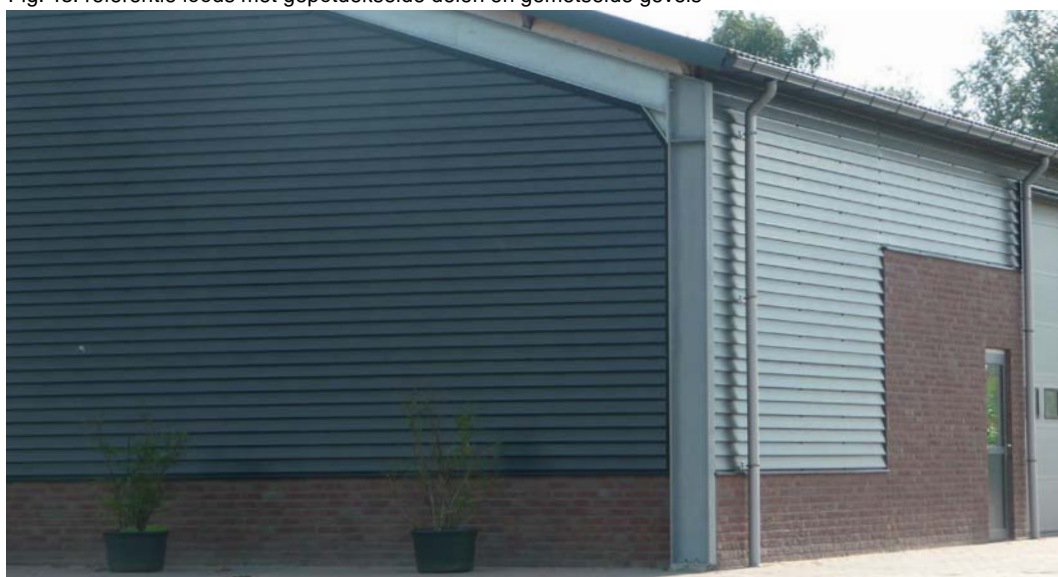
Fig. 16: referentie loods met gepotdekselde delen en gemetselde gevels
