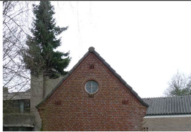
Fig. 11, gebouw met open ventilatiekanalen.
