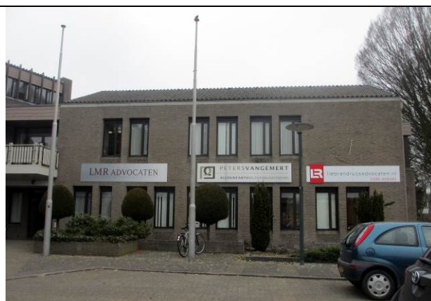
Fig. 6. Deel van het te slopen kantoorgebouw.
