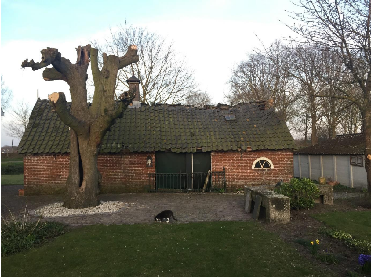
Foto bestaande situatie bakhuisje
