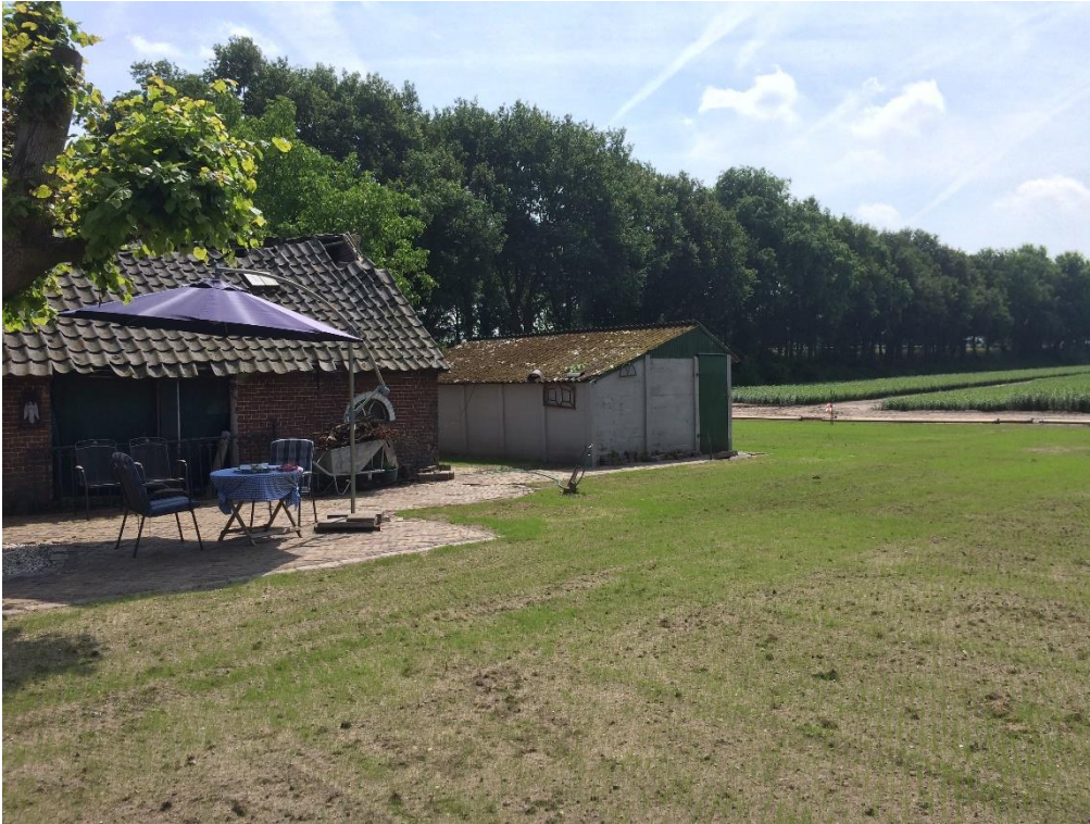
Bijgebouw zoals bovenstaand aangeduid met cijfer 5
