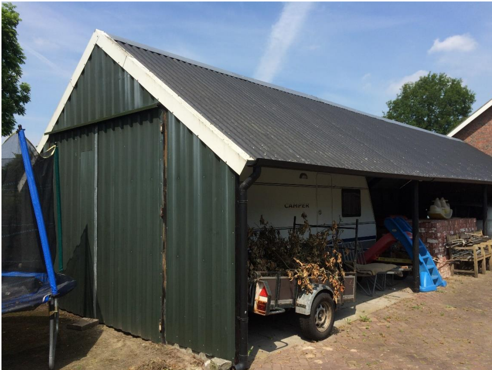
Overkapping zoals bovenstaand aangeduid met cijfer 2
